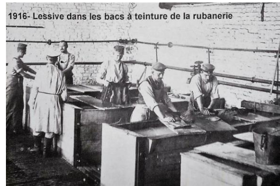
Blanchisserie allemande de l'usine Dalle à Wervicq (1916).
