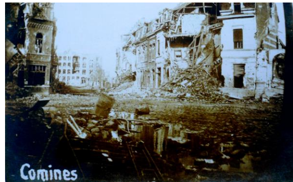
Comines, en 1918. La rubanerie Catteau (au fond, au centre) et la maison de Désiré Ducarin (à droite) sont éventrées.
